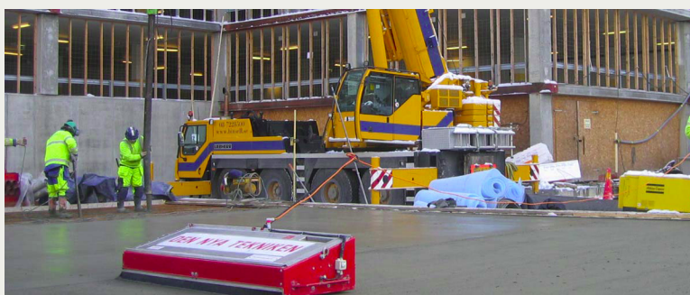
Robot som eftervibrerar betongyta.
